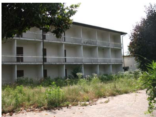
Figura 23 - Area DM 5 - gli edifici dismessi del motel
