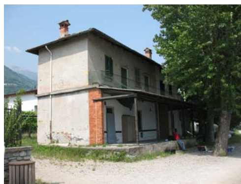
Figura 26 - Area DM 7 - L'edificio lungo la sponda
